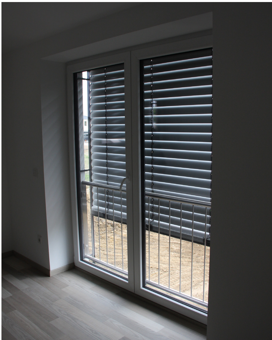
Buitenzonwering met raffstores. Foto: Azimut Bouwbureau
